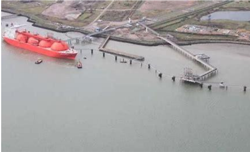
UPSTREAM LNG BERTH
